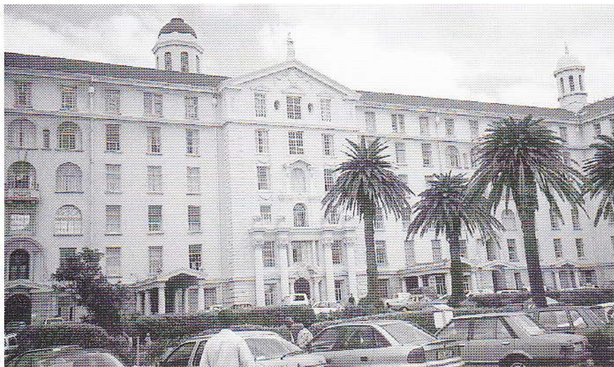
Groote Schuur sjukhuset.
