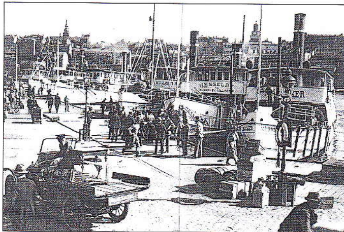
Innan bilarna kom var sjövägen in till Stockholm en viktig transportväg för handelsträdgårdarnas produkter. Här har ångbåtarna lagt till vid Kornhamnstorg vid Slussen. (Bild ur boken, Bilden av Hässelby, av Bernt Josephsson och Harry Grip)
