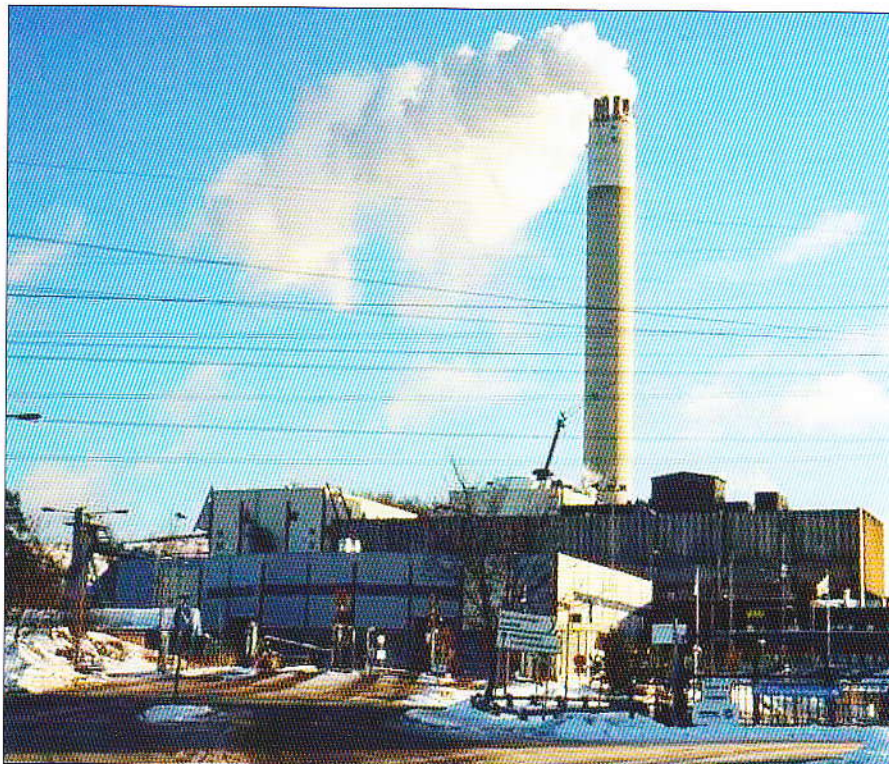
I Högdalens kraftvärmeverk förbränns idag hushållssopor från hela Stockholm. Det ger både fjärrvärme och el. Foto Bengt Johnsson.
